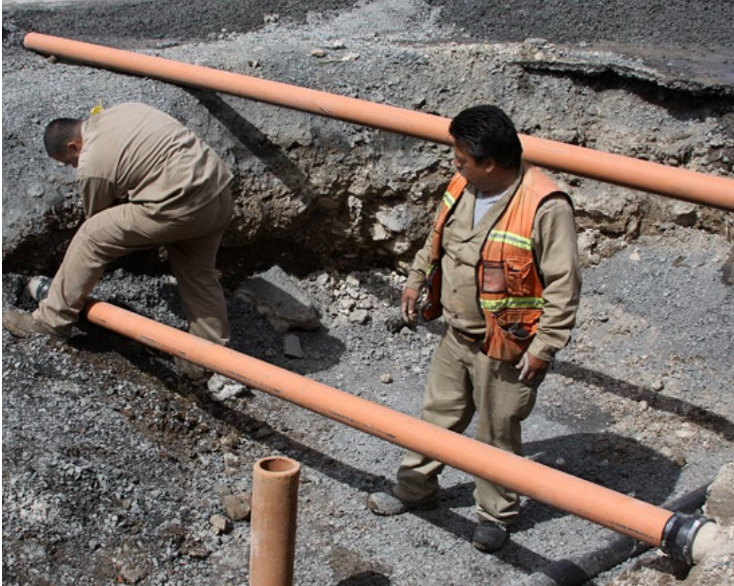
Trabajadores de SADM en obras de mantenimiento y reconstrucción de tuberías.
