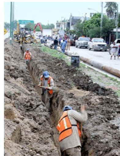
Después del Huracán Alex, con apoyo del Gobierno Federal, SADM invirtió en obras para reconstruir la infraestructura dañada.
