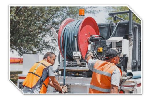
• Funcionan a base de agua que es arrojada a presión al drenaje por medio de una manguera, removiendo residuos para destaparlo o evitar taponamientos.
